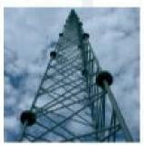
**SLX5/W:**SELF SUPPORTING LATTICE PERMANENT MET TOWER TO 160M
